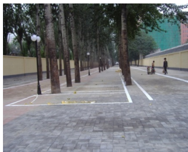
拆除违章建筑改建停车场
